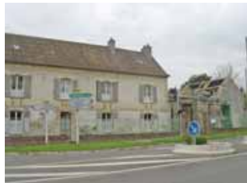
Ancien relais de poste Maison à un étage
