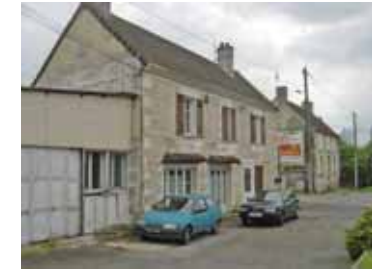
Ancienne construction en cours de réhabilitation
