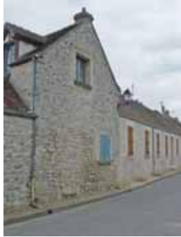
Moellons calibrés et assisés, joints creux, toiture petites tuiles.
