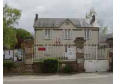
Pignons en briques, mur briques bâtiment en retrait...
