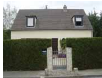
Une hauteur R+C respecté par à la quasi-totalité des constructions récentes
