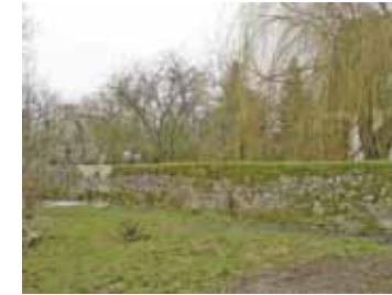
Mur de protection contre les eaux à l'intérieur des parcelles
