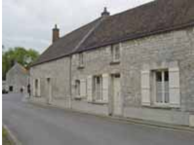
Moellons calibrés et assisés, joints creux, toiture petites tuiles.
