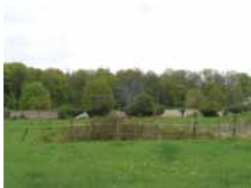
Mur entourant l'ancien potager du château (village), visible en entrée de village
