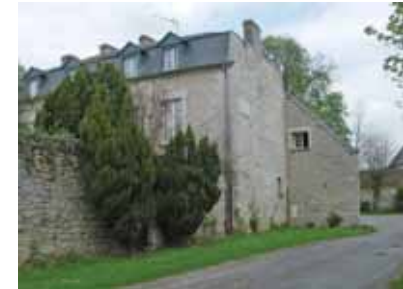
Pierre de taille en chaînon aux angles, toiture mansardée à deux pentes, pignon à l'arrière et toit deux pentes.
